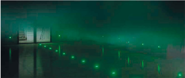
Abb. 10: Ein bodennahes Leitsystem bietet auch bei Verrauchung Orientierungshilfe.
