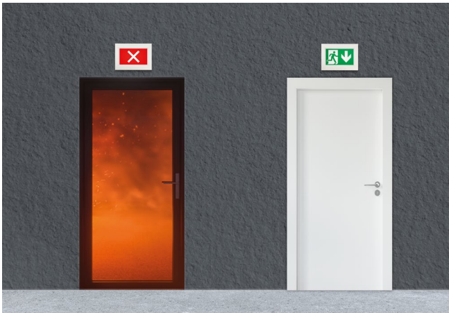
Abb. 8: Die richtungsvariable Rettungswegkennzeichnung erlaubt eine dem Gefahrenfall angepasste Ausschilderung.
